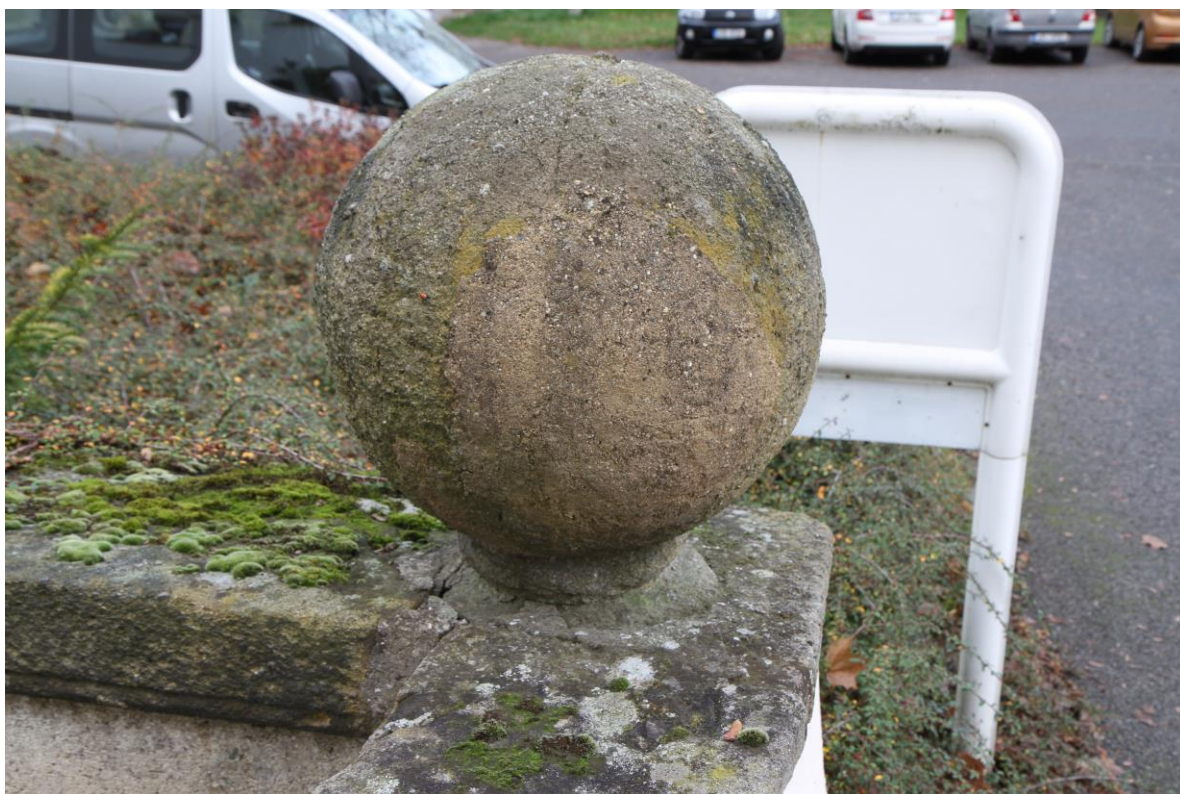
Detail kamenného čučku s druhotnou plombou
