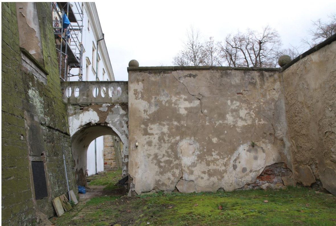
Pohled na mostek od východu, po pravé straně patrné prasklin v omítce a vyvalování zdiva
